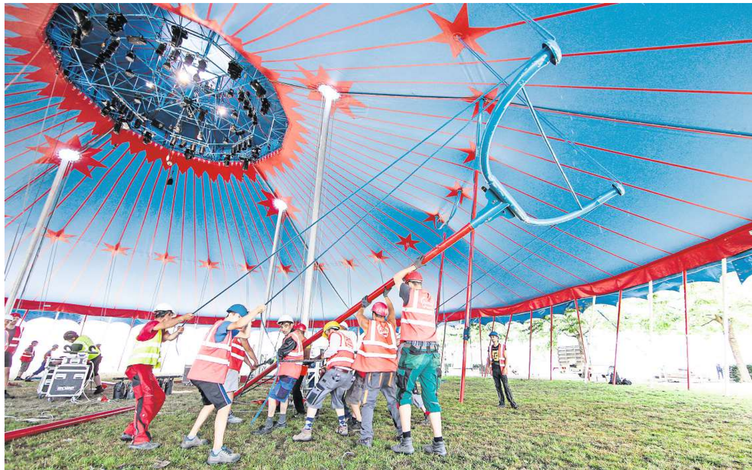
Vier Hauptmasten und 88 Rondellstangen müssen die Mitarbeiter errichten, bis das Zelt sicher steht.
