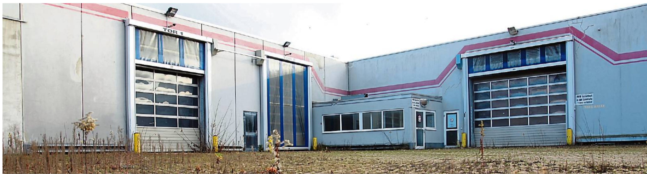
Verwuchert zeigt sich das Coca-Cola-Werk in Haste drei Jahre nach der Schließung. Künftig will die Hochschule Osnabrück das Gelände für ihre Zwecke nutzen.
