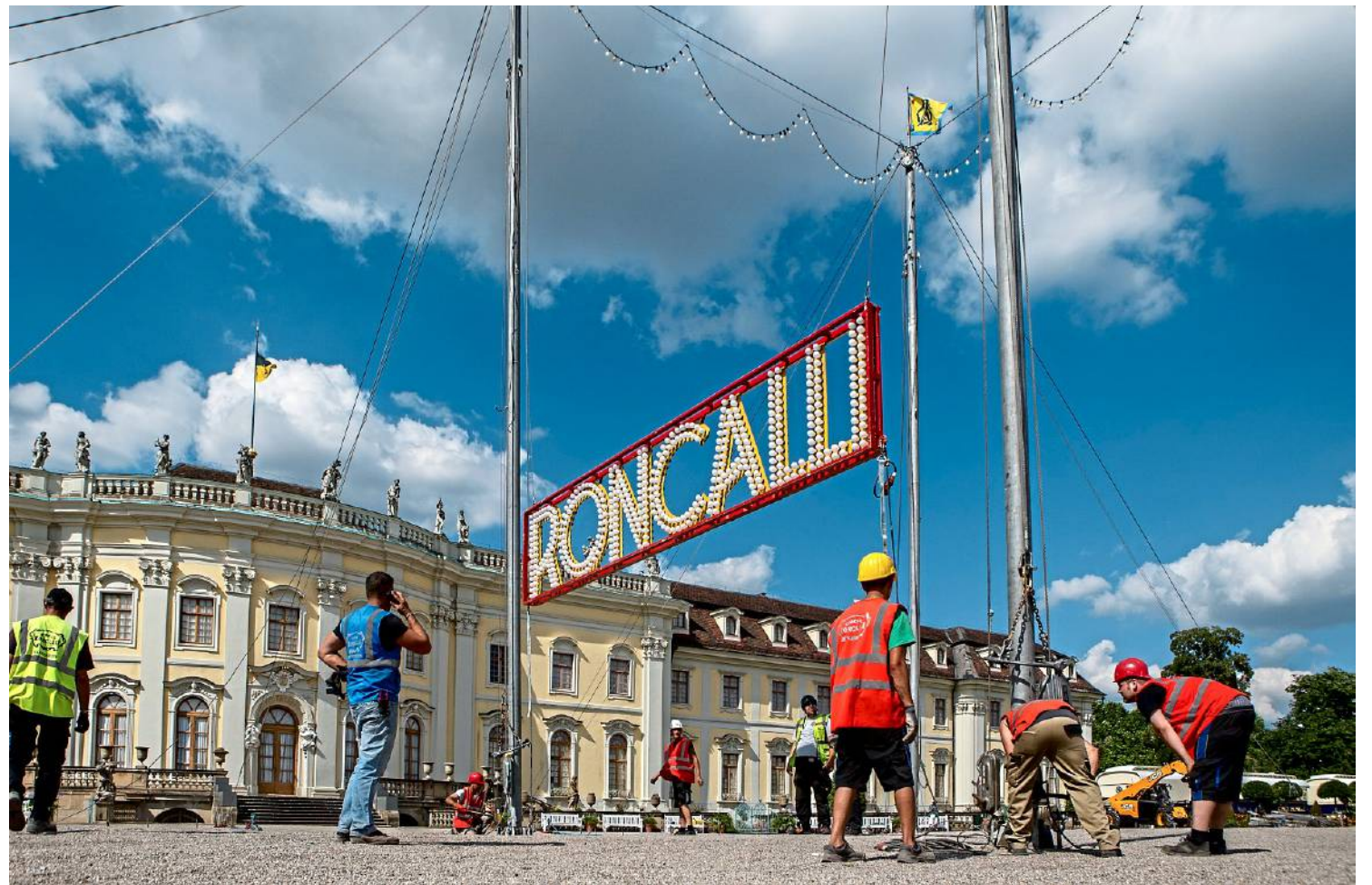
Nach der Ankunft des Sonderzugs startet direkt der Aufbau vor dem Residenzschloss: Am Donnerstagnachmittag stehen schließlich die vier 16 Meter hohen Masten des Hauptzelts. Komplett fertig wird das große Circuszelt aber erst am heutigen Freitag.
