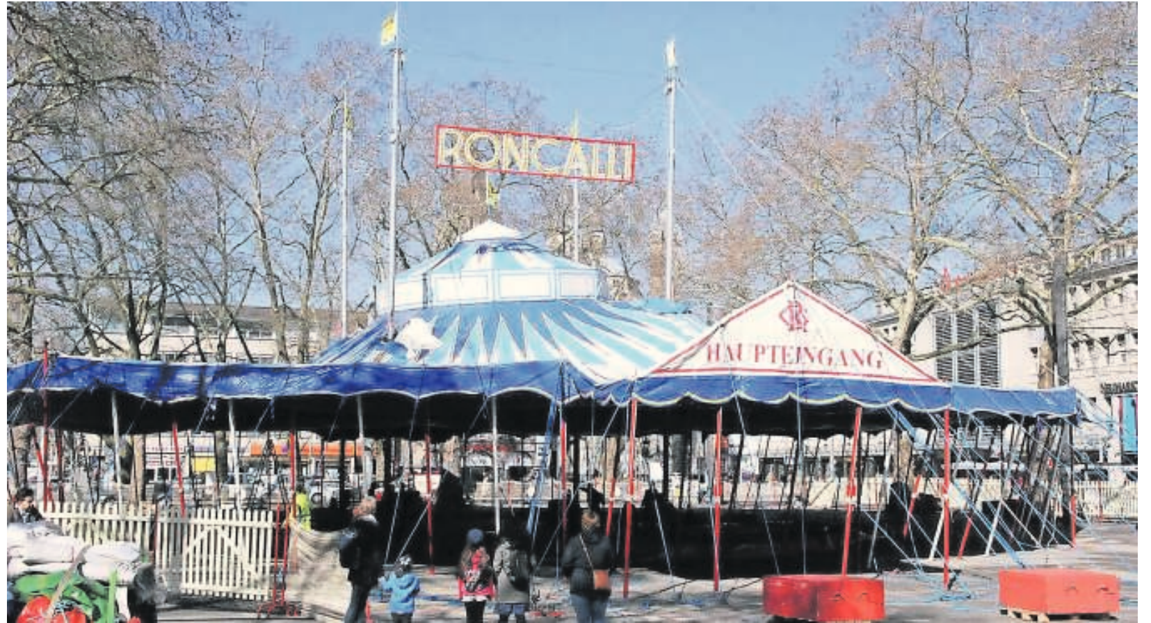
Zwei Tage braucht es, bis das 25-köpfige Team das große Zelt des Circus Roncalli aufgebaut haben. Die Inneneinrichtung beginnt in der kommenden Woche. Das Zelt hat einen Durchmesser von gut 36 Metern und ist an seiner höchsten Stelle 16 Meter hoch. FOTO: STEPHAN EPPINGER
