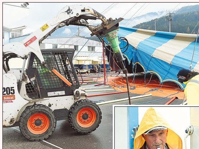
▲ Mit einem großen Kompressor werden die 4 Kilo schweren Verankerungen in den Asphaltboden gerammt.
